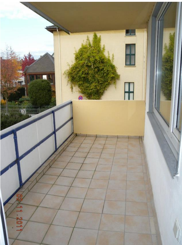
Balkon (wurde mittlerweile neu gestrichen)
